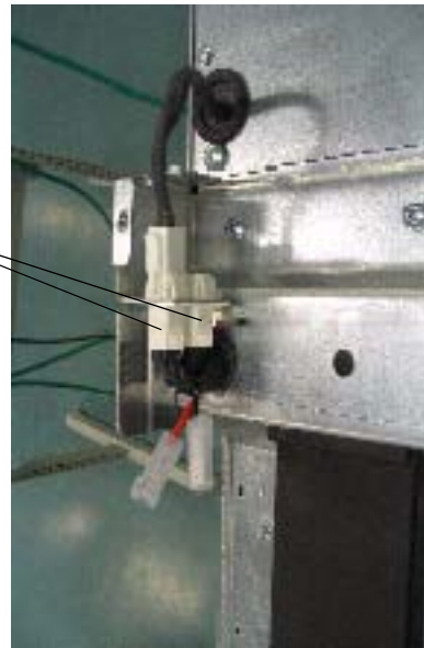
Fan inverter cable connectors
